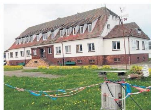
► Budynek portu jachtowego wygląda już inaczej. Wymieniono stolarkę okienną, drzwi, naprawiono dach. Jest nowe ogrzewanie
