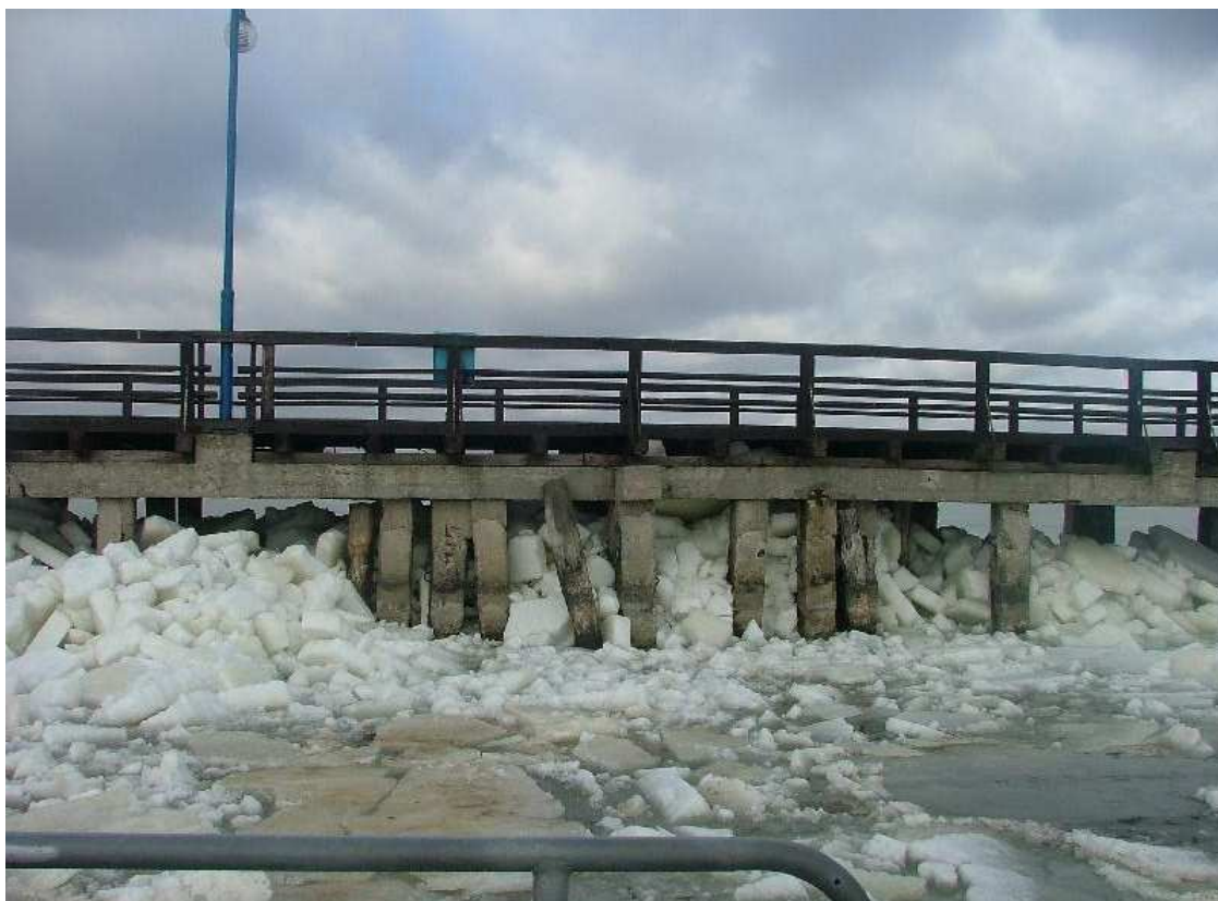
Rys.11. Spiętrzenie pola lodowego, port jachtowy w Pucku, marzec 2006.
