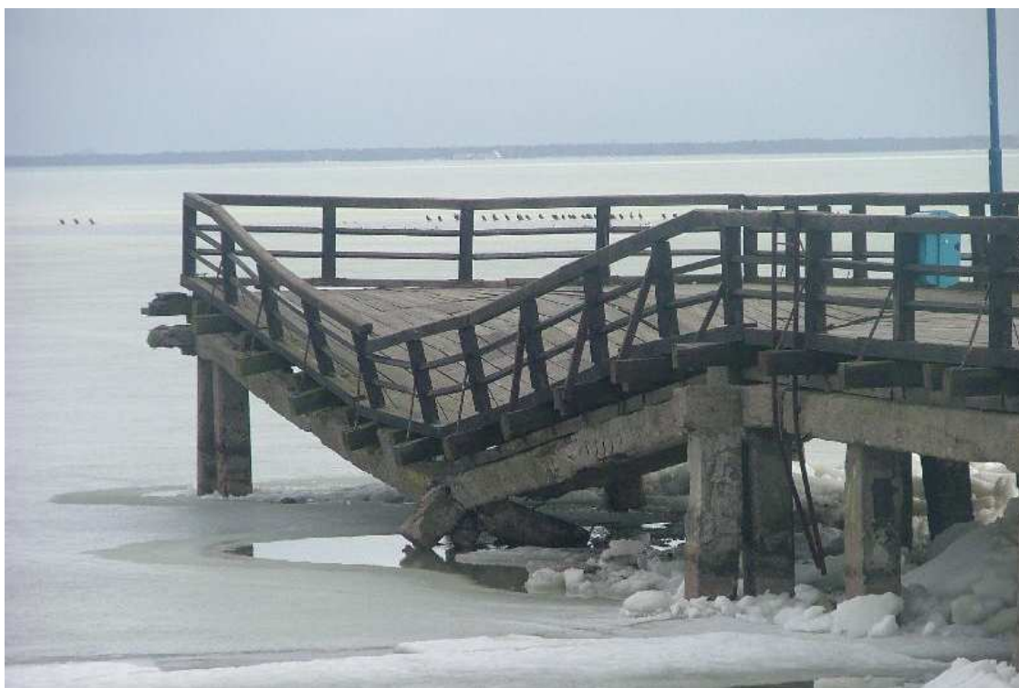
Rys.12. Uszkodzone moło spacerowe, port jachtowy w Pucku, marzec 2006.
